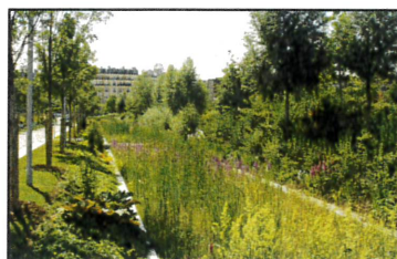
Végétalisation des noues
